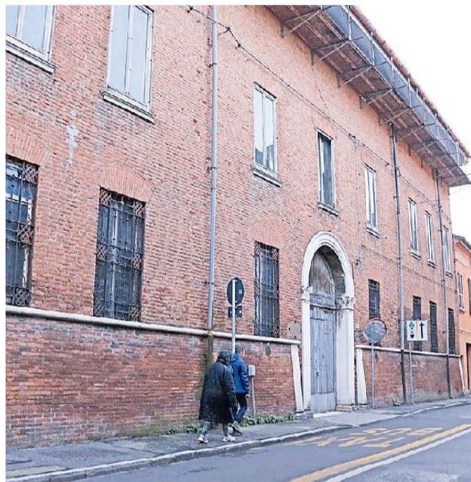
Palazzo Melli in via Carlo Mayr a Ferrara, intervento al tetto
